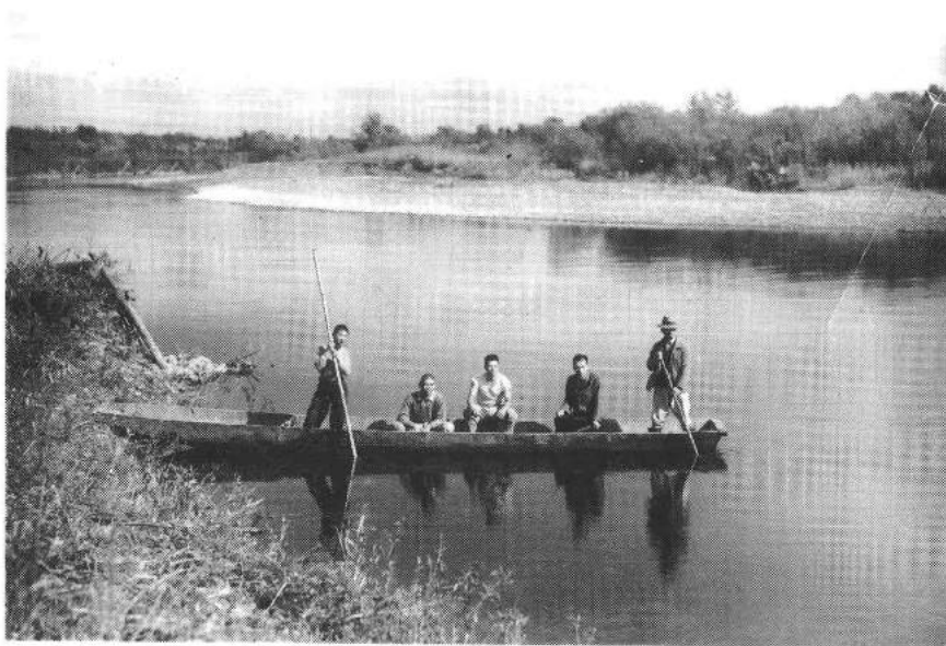
昭和28年 天塩川切替工事測量時に撮影
