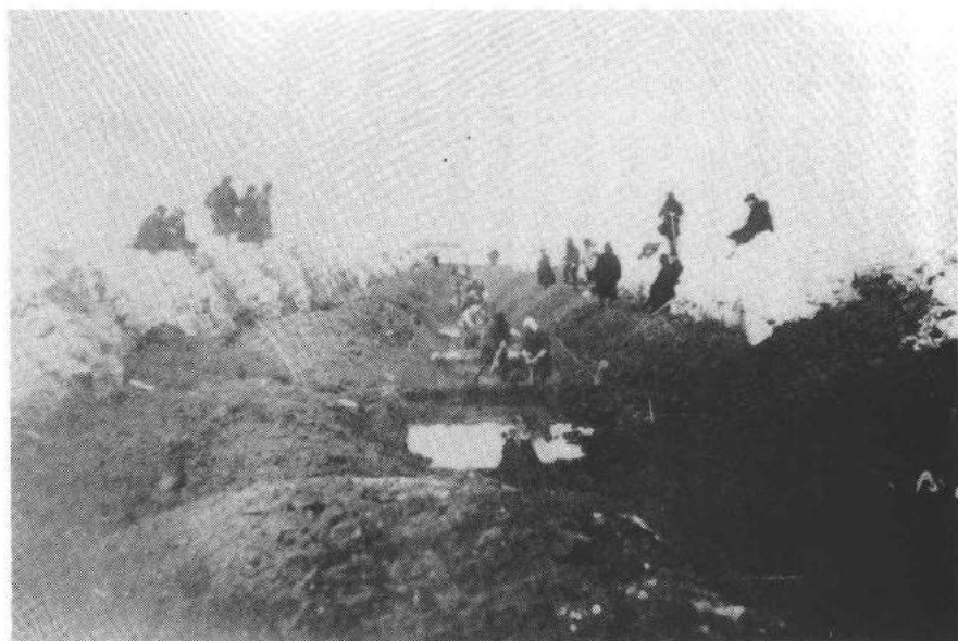
新タヨロマ川放水路の堀削
