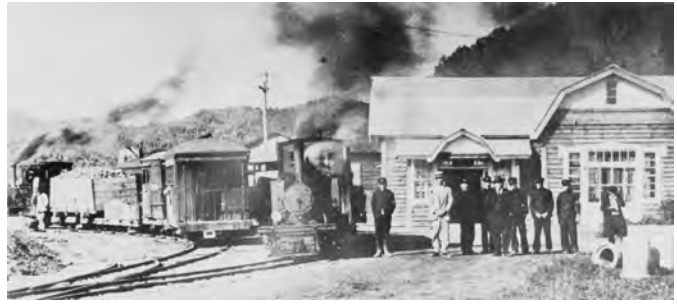
上士別駅、中央機関車は三号車前に線路の重りをつけているのがわかる（高橋秋雄氏提供）
