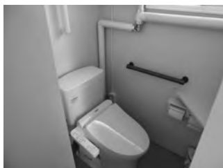
待合室トイレ全面改修
