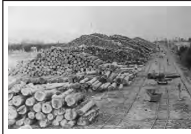
士別駅構内 貯木場 右に軌道の側線、左に国鉄の側線がある
