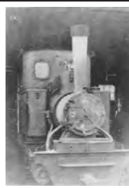
1号蒸気機関車 (士別駅構内)
