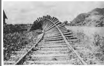
洪水で押し流された軌道
