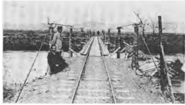
応急工事で完成した吊り橋の状況
